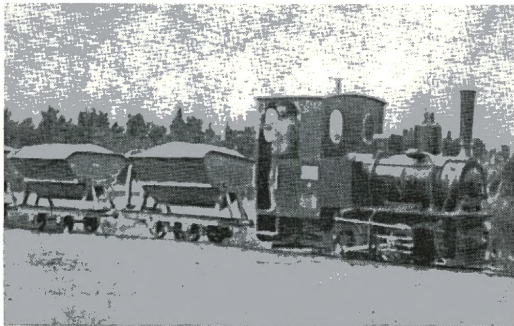
5. Excavación del Lago de Regatas. (AA)
