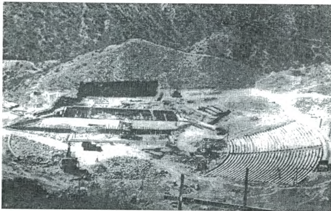
36. Teatro Griego en Construcción. (LGV)
