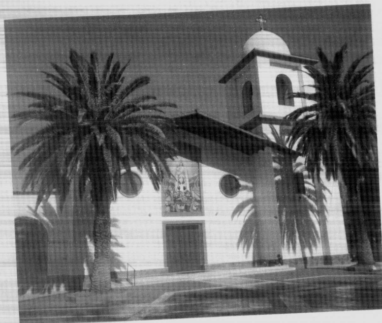
Frente de la Iglesia de la Carrodilla
