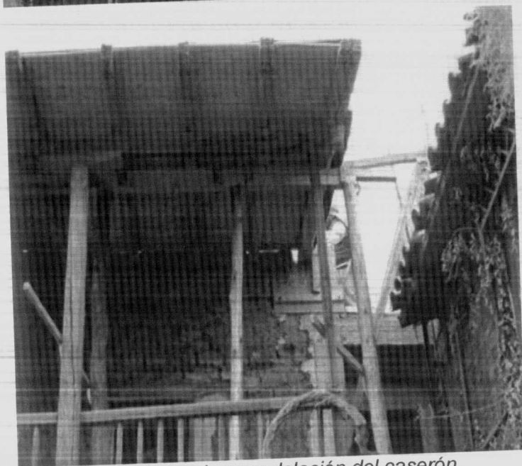
Trabajos de remodelación del caserón
