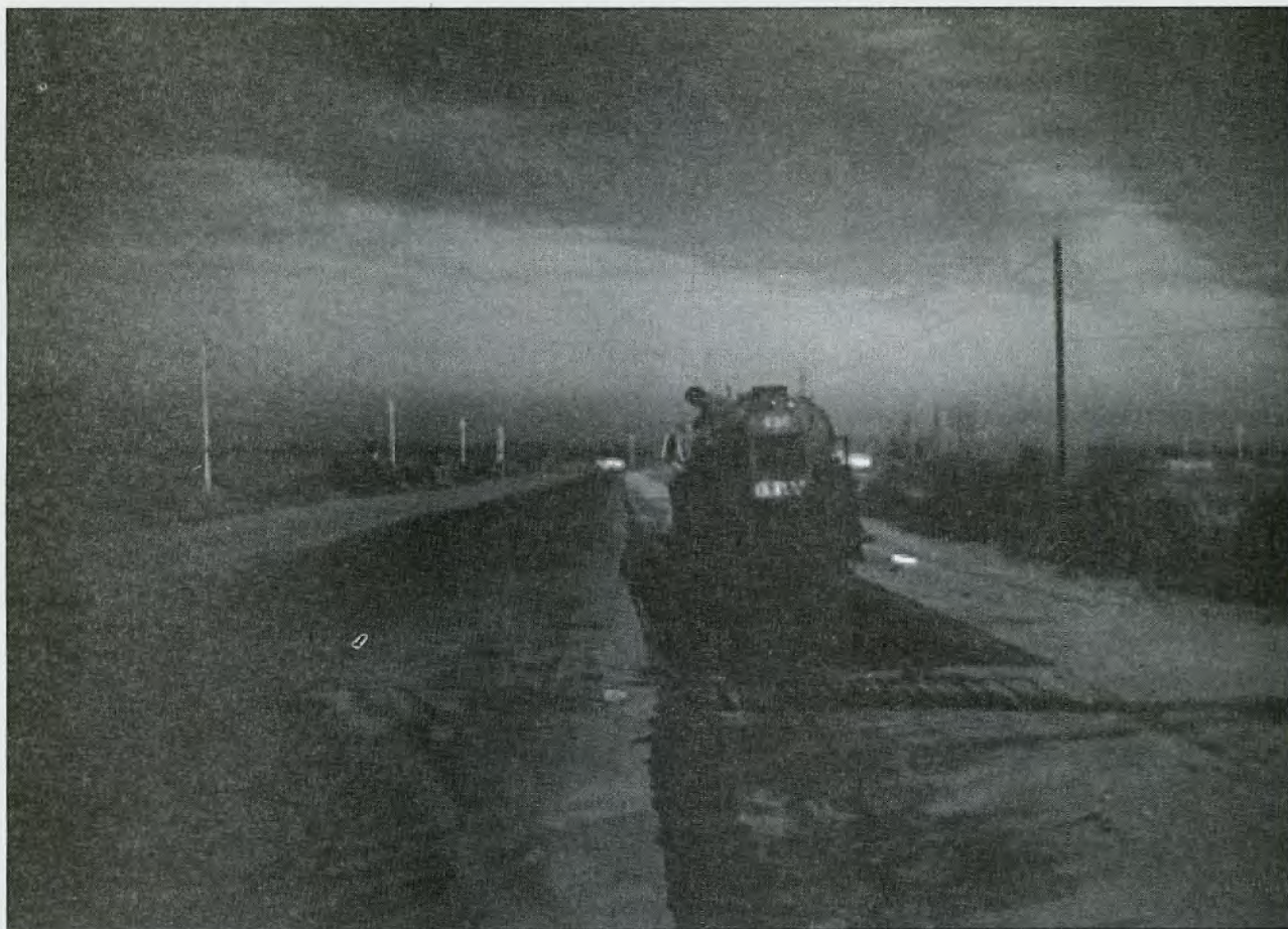
Tratamiento de banquina en la Ruta Provincial 88, departamento de Tupungato.
