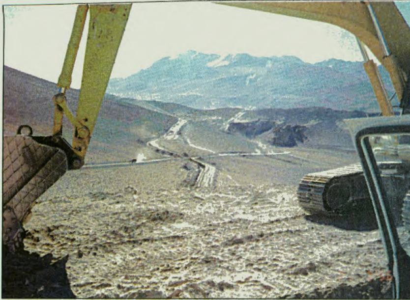
Camino a la Laguna del Diamante. Máquinas viales construyen el gasoducto.
