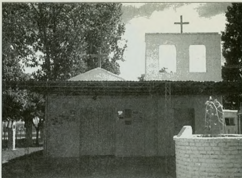
Vista exterior de la capilla de Santa Rosa de Lima (Las Pintadas).
