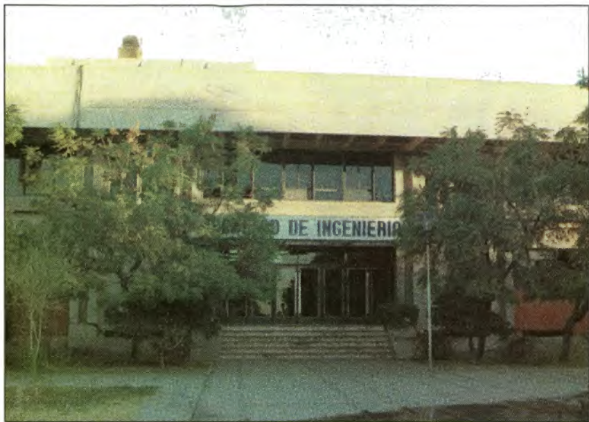
Sede de la Facultad de Ingeniería.
