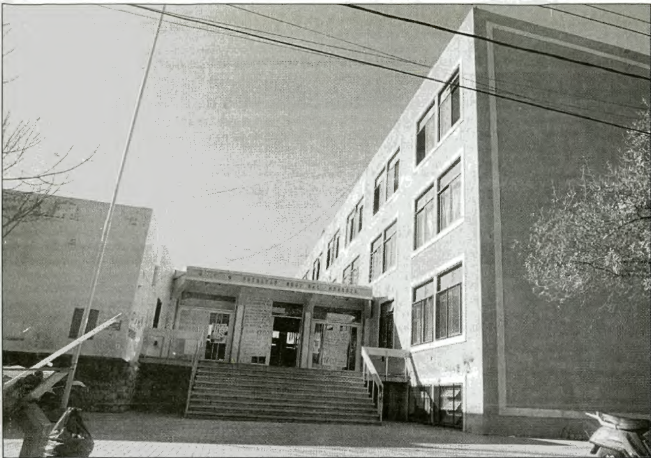
Edificio de la Universidad Tecnológica, ubicado en calle Coronel Rodríguez de Ciudad.
