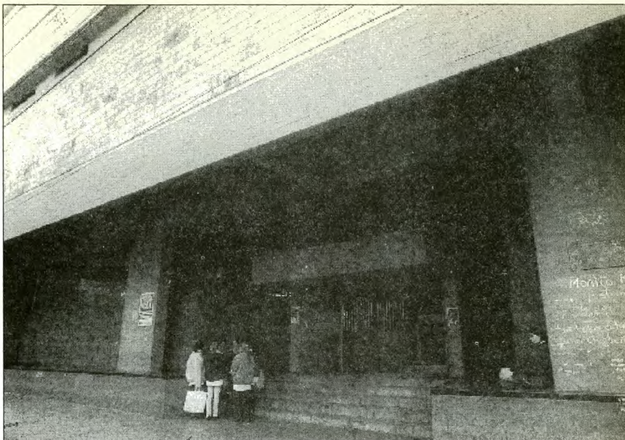
Puerta de ingreso al Colegio Universitario Central.
