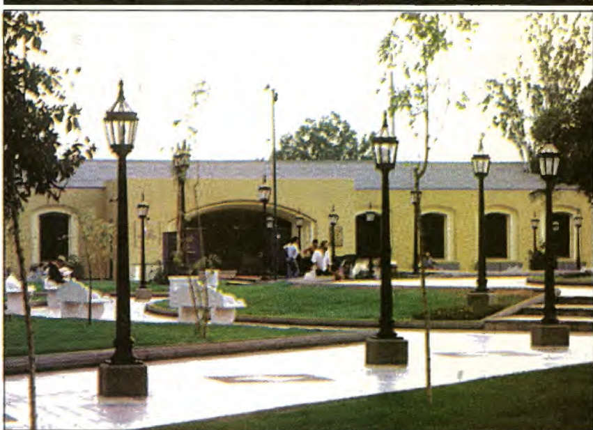
Plaza Pedro del Castillo, remodelada por la Municipalidad de la ciudad de Mendoza en 1993. En esa oportunidad se construyó el Museo del Area Fundacional, cuya edificación de color camel se observa en la fotografía.
