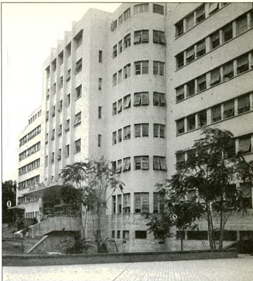
Hospital Central de la ciudad de Mendoza. Fue inaugurado de apuro, en 1944, a raíz del sismo que destruyó San Juan.
