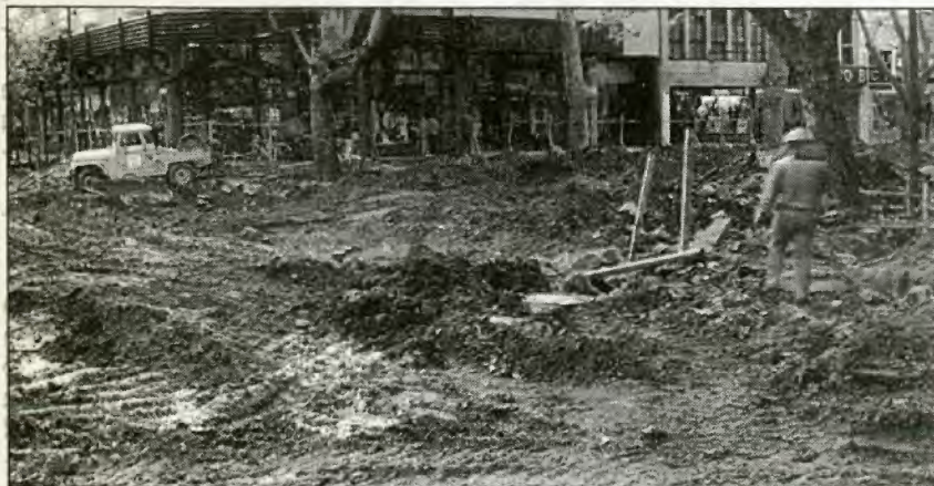
Trabajos de remodelación de la avenida Las Heras realizados por la Municipalidad de la ciudad de Mendoza.
