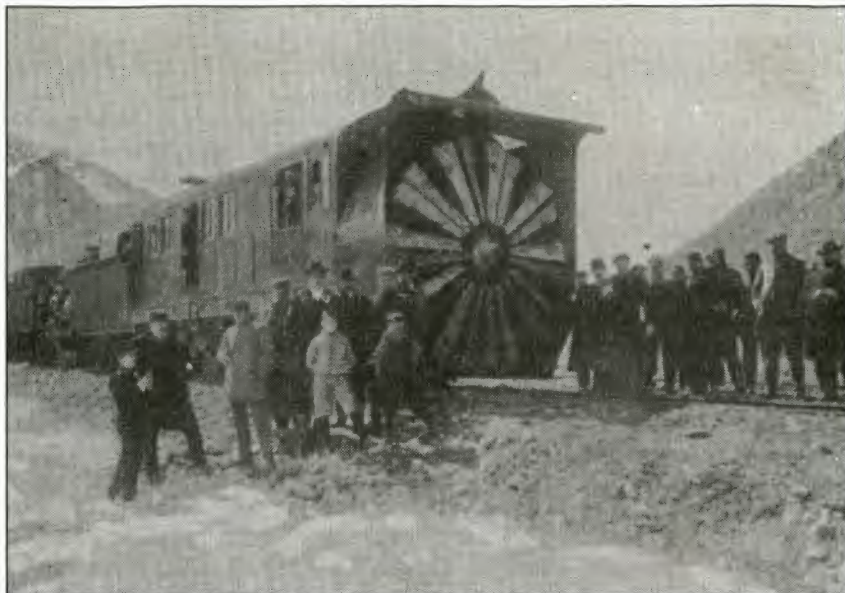
Máquina quitanieve. Era utilizada para despejar la nieve de las vías que conducían a Chile y evitar de esa manera la incomunicación con el país vecino.
