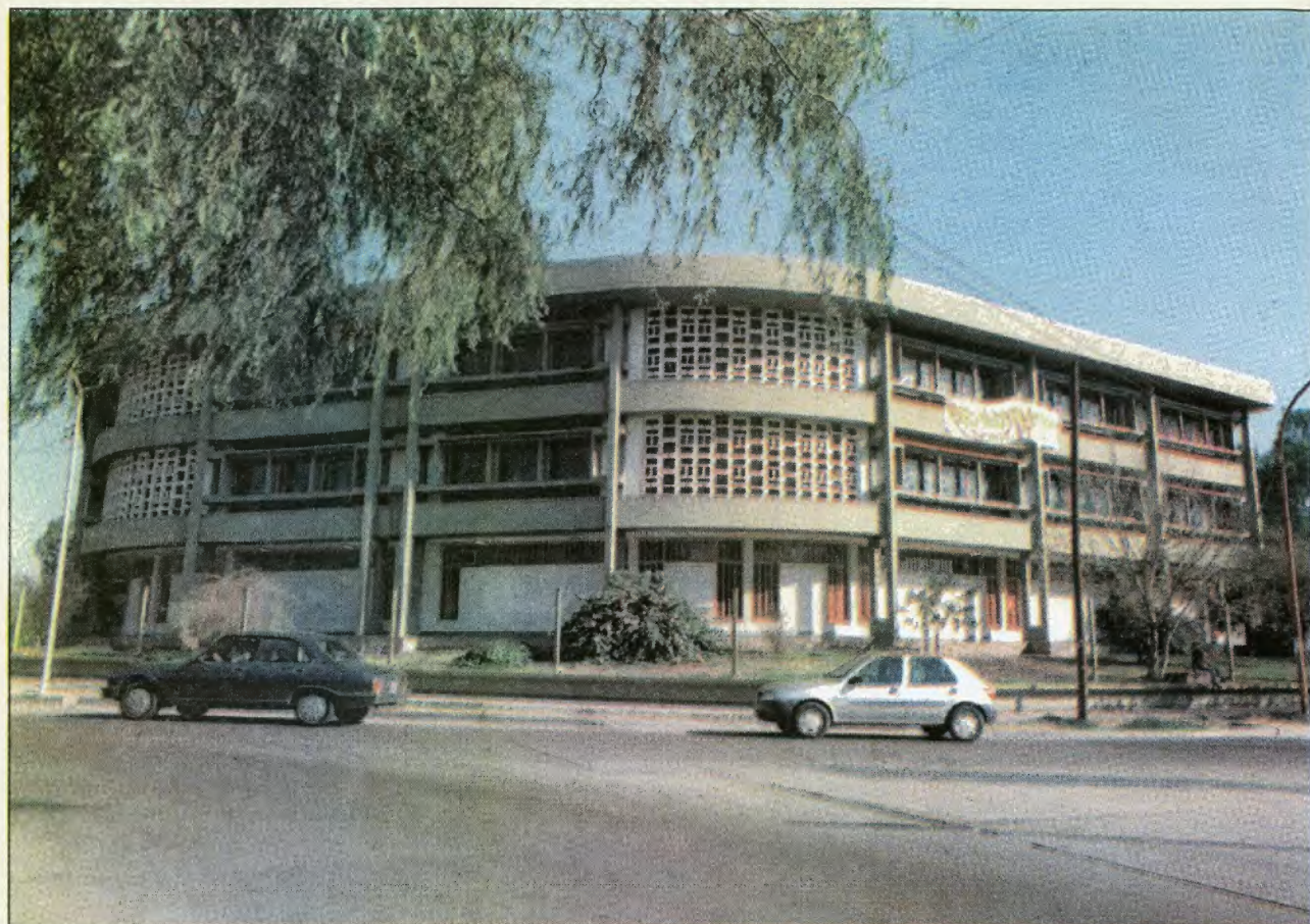
Edificio utilizado por el Magisterio.
