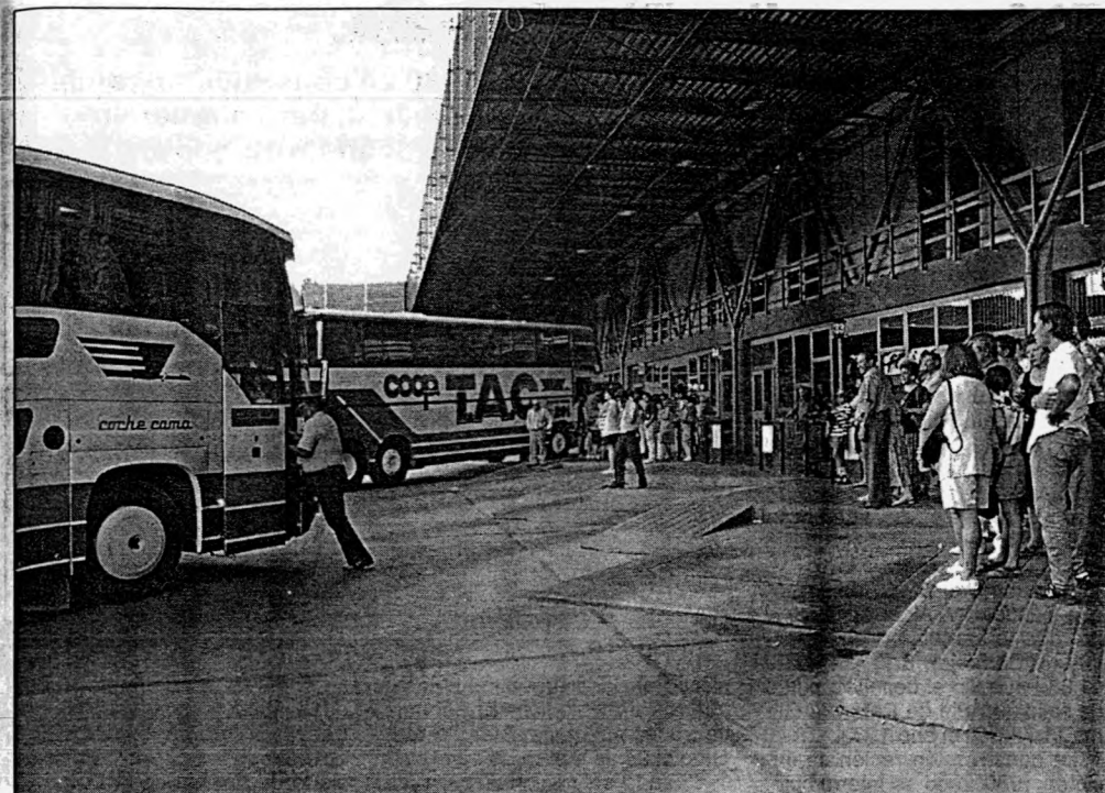
Estación Terminal del Sol, remodelada en mayo del '95.
