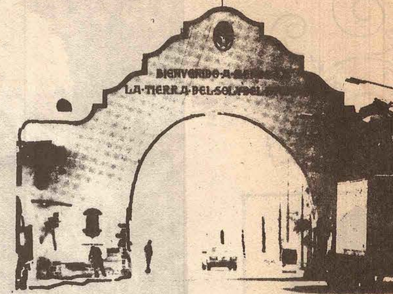
Arco de Desaguadero.
