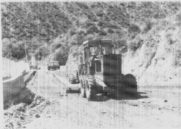
Personal de Vialidad Provincial ya concretó el 95% de las mejoras en los accesos al anfiteatro.
