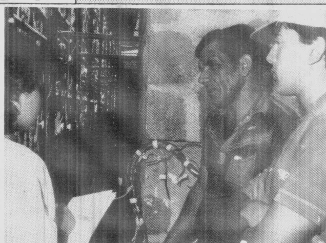
Silvio Ochoa, oficial a cargo de las instalaciones eléctricas del escenario central. Veinte efectos lumínicos para un solo friso.
