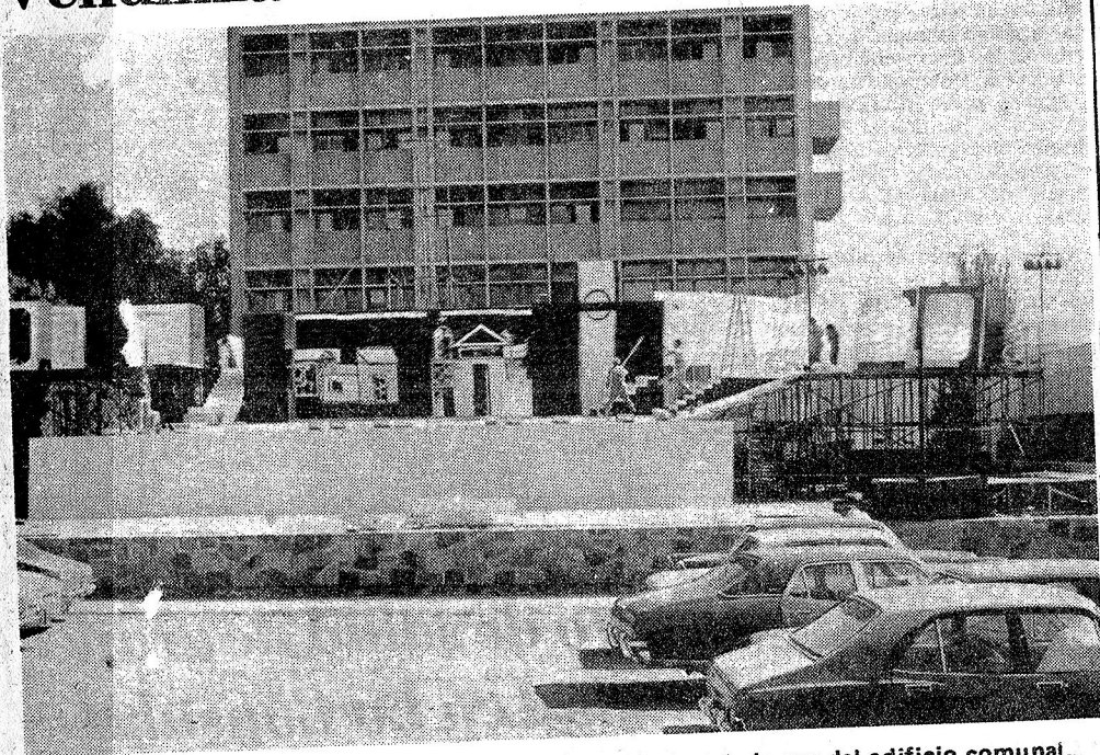
Aspecto que presenta el escenario que se levanta en el costado sur del edificio comunal.
