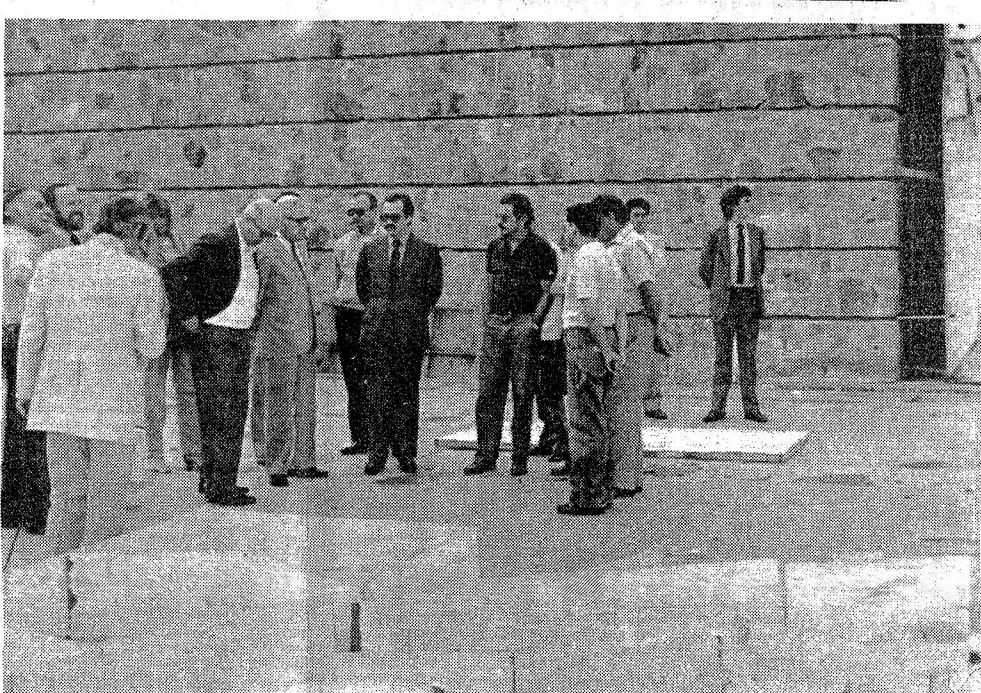
El mandatario provincial recorrió ayer las obras que se realizan en el anfiteatro Frank Romero Day para el montaje del espectáculo central de la Vendimia '84.
