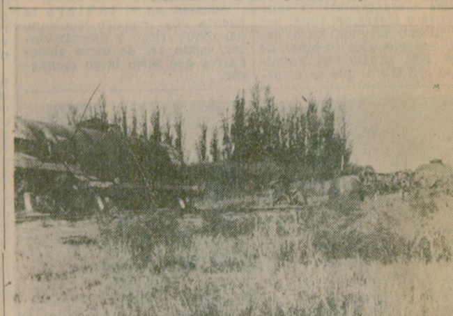
Una vista del estado en que quedaron los vagones, luego de descarrillar y enterrarse en el terraplén.
