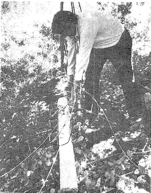
Otro operario de la empresa estatal Agua y Energía, repara los conductores en el suelo, para luego colocar el poste en el lugar correspondiente.
