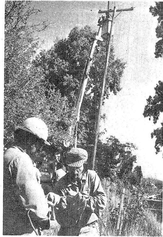
Obreros de Agua y Energía, empalman los cables cortados por la tormenta del domingo último. A la derecha puede observarse una torre caída sobre un viñado.
