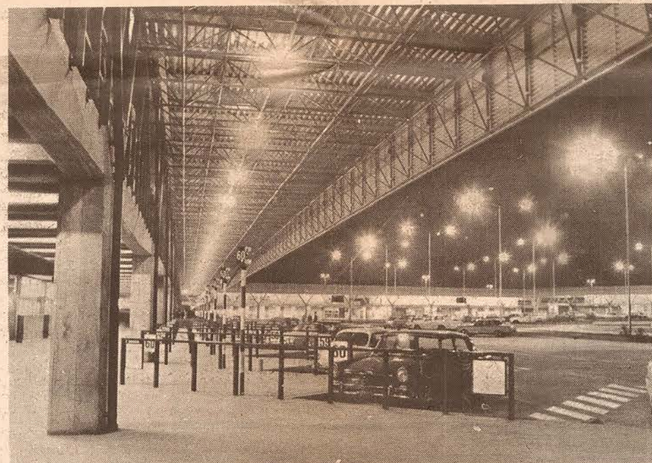
En la Terminal de Omnibus convergen líneas nacionales e internacionales que desplazan viajeros desde y hasta toda la provincia y el país.
