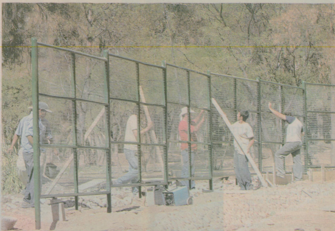
Comienzos. Personal de la Comuna empezó los trabajos de cierre perimetral. Prometen la apertura para fin de año.
