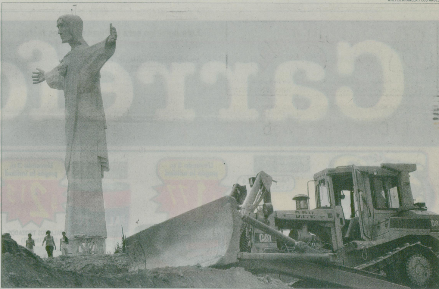
PAISAJE IMPONENTE. Las máquinas ya trabajan en el lugar donde se hará la Bendición, a más de 1.400 metros de altura.
