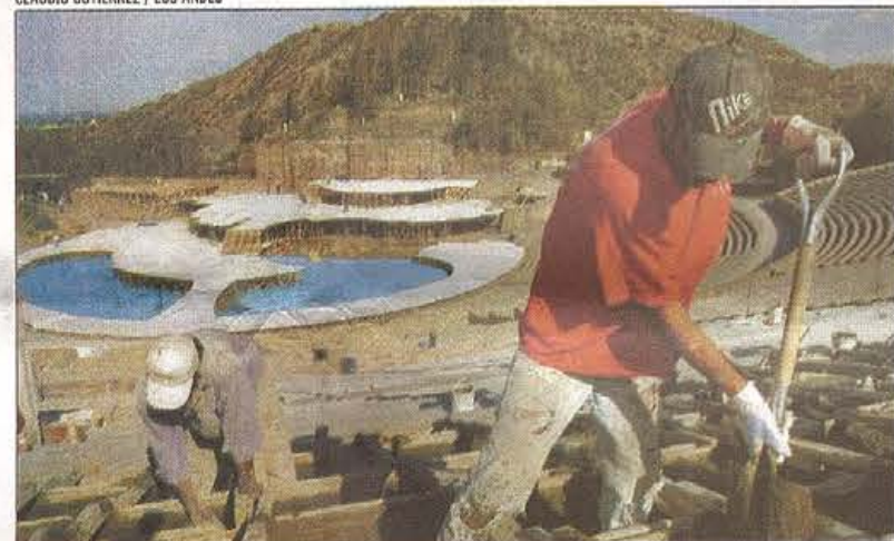
A estrenar. Sanitarios y las gradas del sector Tempranillo.
