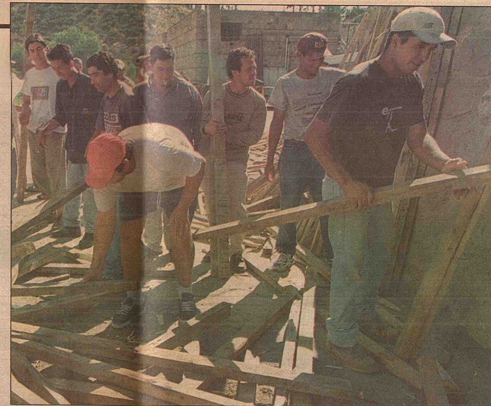
Luego de terminada la obra, inspectores del Ministerio de Ambiente y Obras Públicas revisarán la construcción para comprobar que se cumplan todas las normas de seguridad necesarias.
