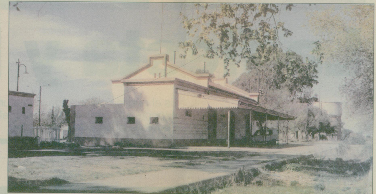
La estación ferroviaria de Alvear Oeste, un ícono de la zona.
