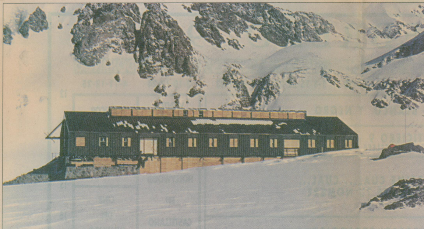
El hotel-refugio Plaza de Mulas trabajó nuevamente completo en la temporada.
