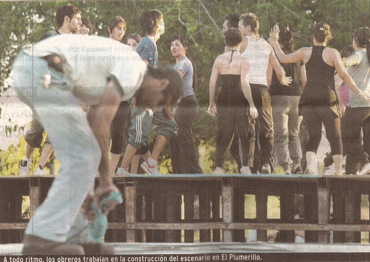
A todo ritmo, los obreros trabajan en la construcción del escenario en El Plumerillo.
