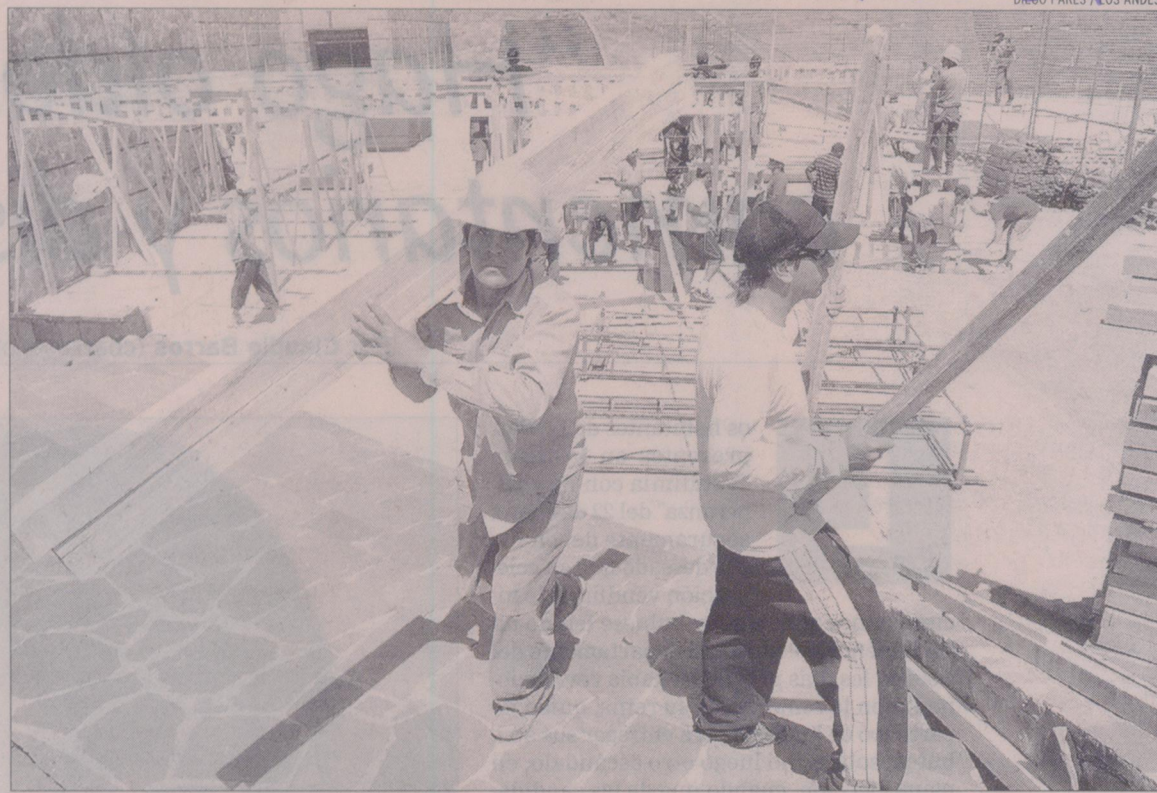
CONTRARRELOJ. Operarios de la empresa contratista en la ejecución del piso de uno de los escenarios.
