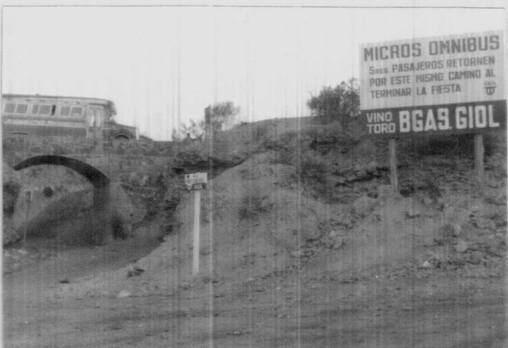
⑪ Pasaje bajo el puente - Señalización deficiente -
