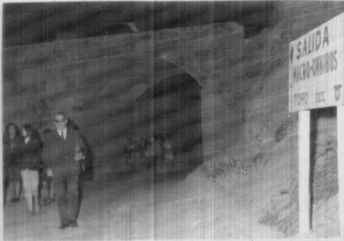
⑫ Pasaje bajo el puente - 21.15 hs. Falta adecuada iluminación y señalización en la entrada -
