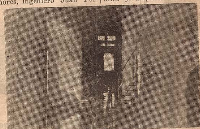
Otro detalle del interior de la bodega Robino. La sección de piletas, como puede apreciarse en el grabado, está revestida con azulejos, lo que asegura una perfecta higiene y proporciona agradable vista al conjunto.
