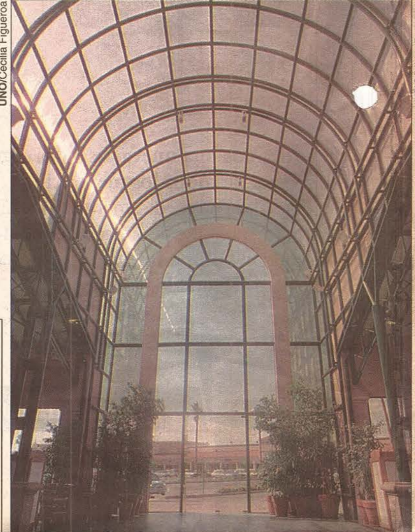
Una llamativa cúpula de vidrio ha sido construida en el patio de comidas.
