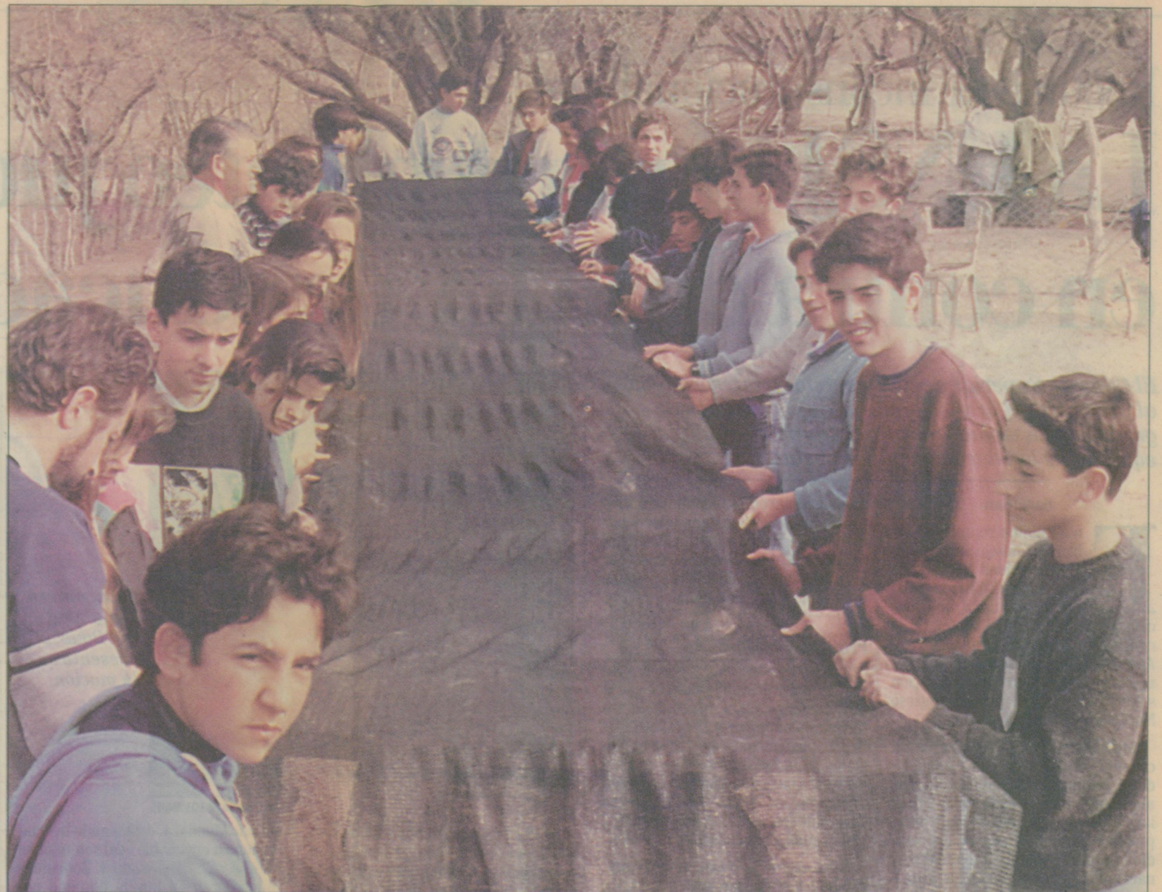
Armada la estructura, se coloca la tela media sombra (permite un 85% de retención de la luz), cosiéndose los bordes.
