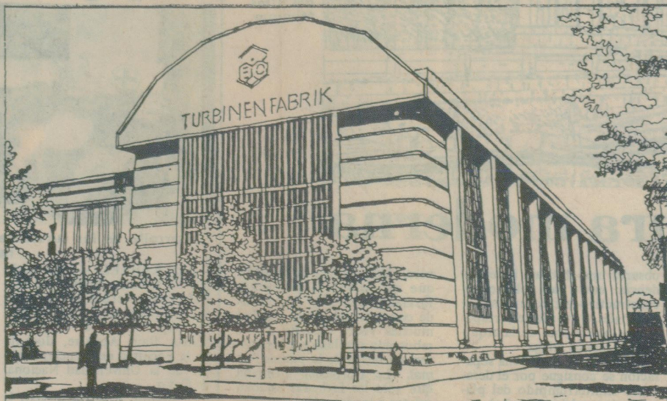
La fábrica de turbinas AEG, de Berlín (1909), considerado por Summerson como un edificio revolucionario. Es la más famosa construcción de Peter Behrens.
