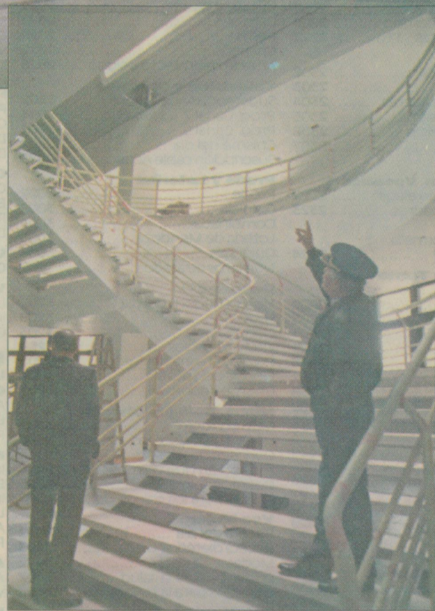
El jefe de aeropuerto Comodoro Héctor Luis González resalta detalles de la escalera que da acceso al sector de confiterías y operacional de las empresas aéreas.
