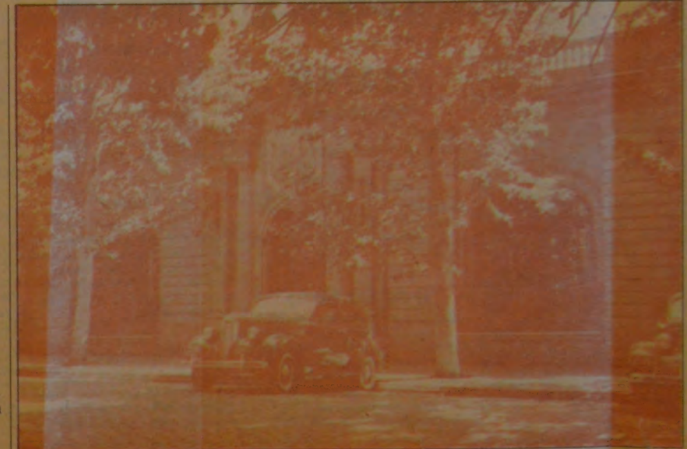
FRENTE DEL CLUB DE GIMNASIA Y ESGRIMA EN LA PRIMERA MITAD DE ESTE SIGLO.
