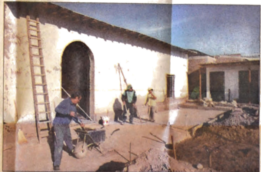
Obras de restauración. Las concretas la Municipalidad con el apoyo de la Dirección de Patrimonio e Infraestructura Cultural del Gobierno de Mendoza. Serían inauguradas en el bimestre julio-agosto.
