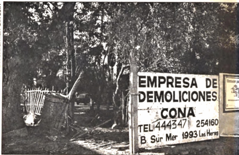
La empresa hace el trabajo para el cual ha sido contratada.
