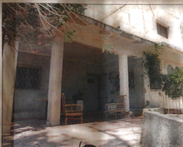
La "fortaleza" dominaba el paisaje, afirmada en un terraplén. Para acceder a la galería principal había que traspasar catorce escalones.
