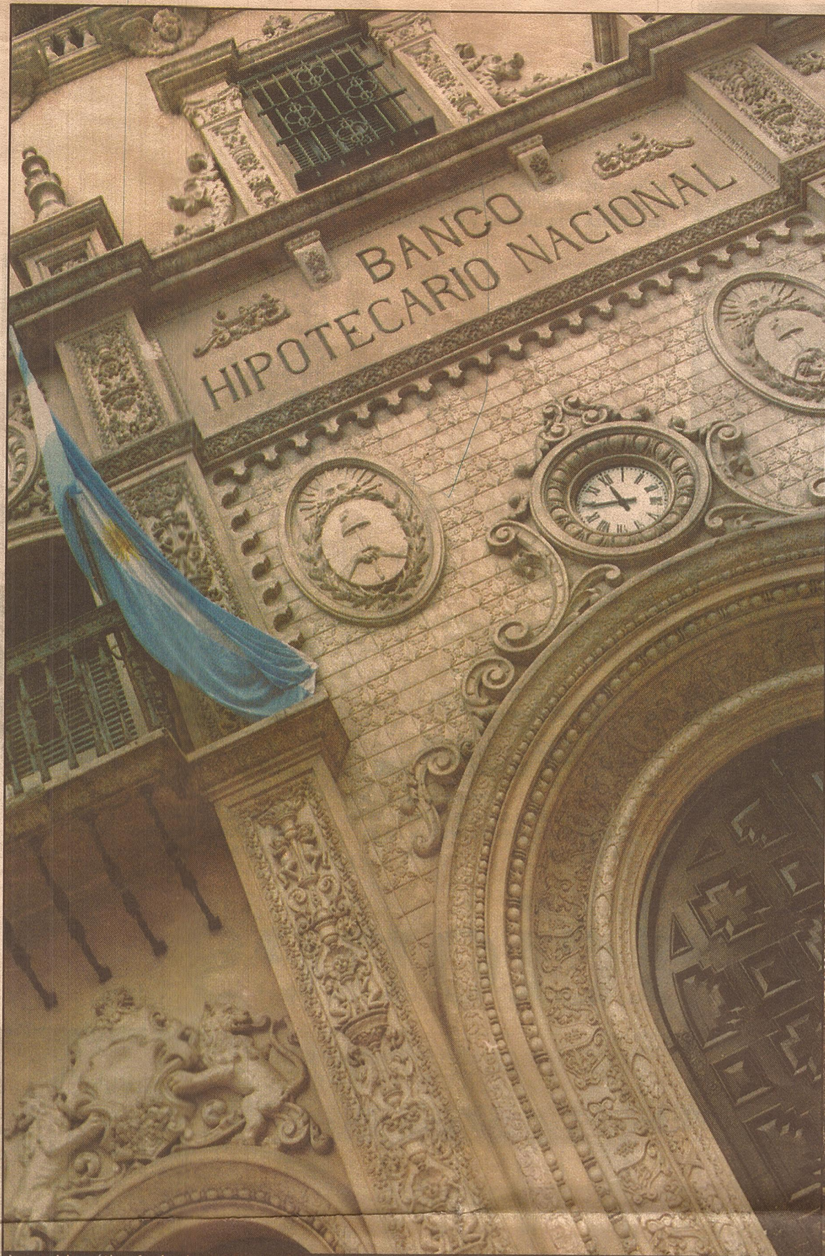
La emblemática fachada del Banco Hipotecario Nacional, orgullo arquitectónico de Mendoza.
