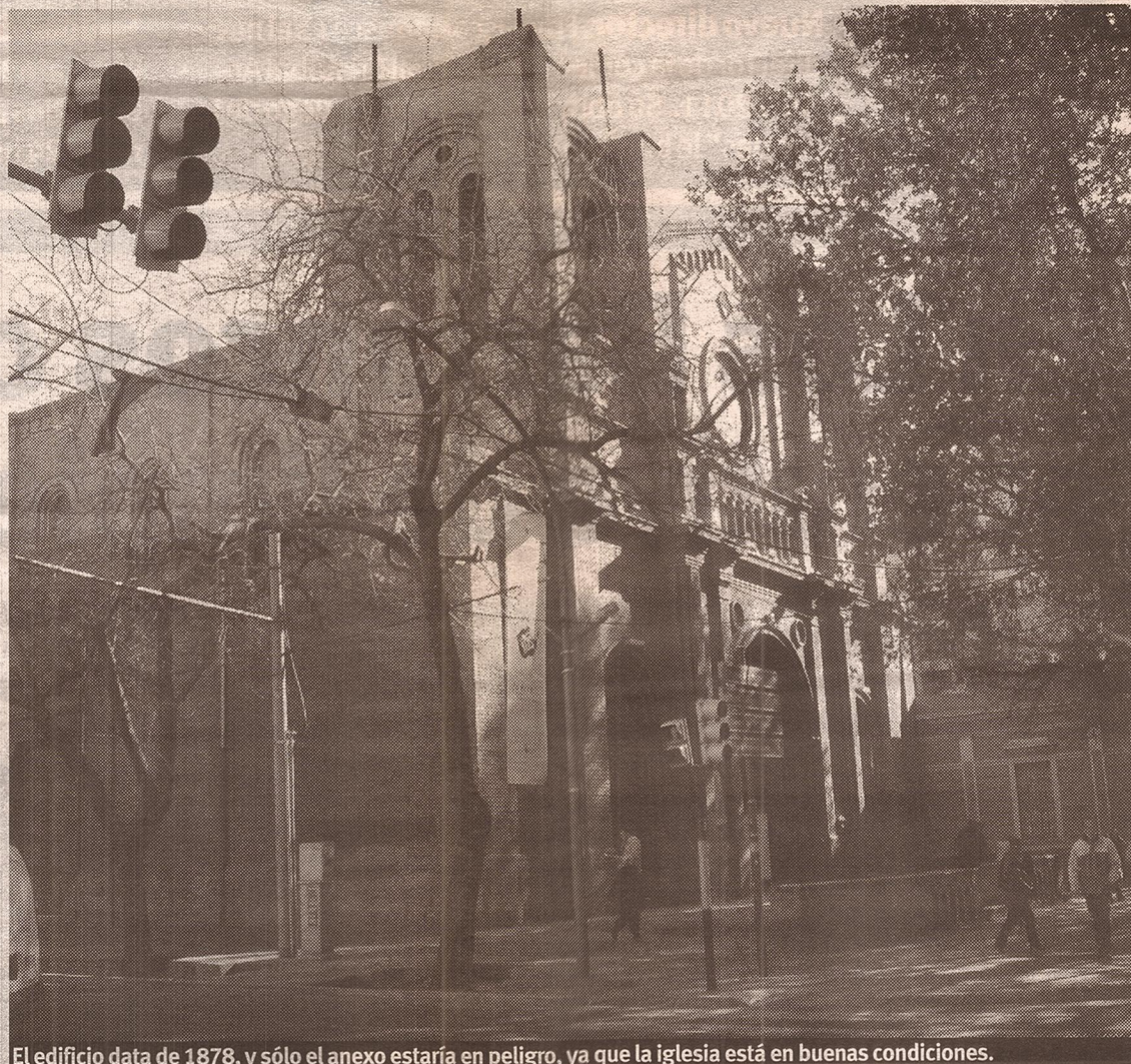
El edificio data de 1878, y sólo el anexo estaría en peligro, ya que la iglesia está en buenas condiciones.
