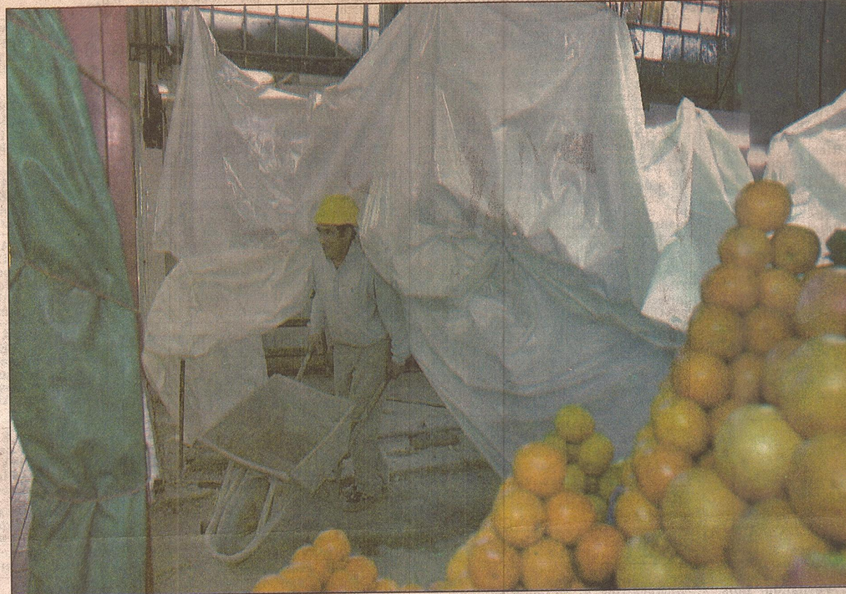
Trabajando entre las frutas. Las obras comenzaron hace 90 días y en la municipalidad creen que estarán terminadas para fines de noviembre.
