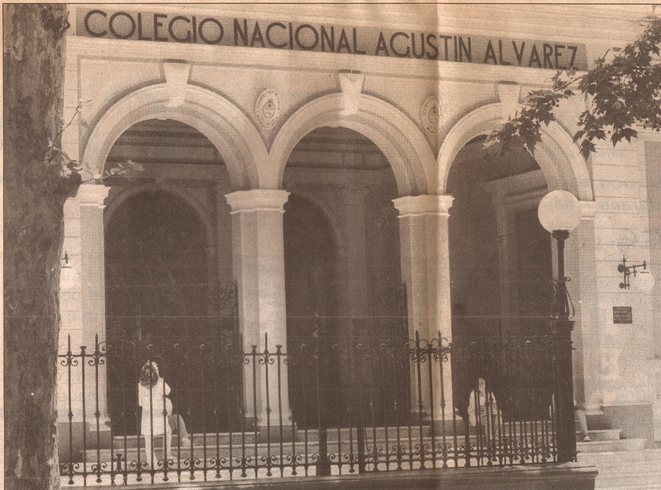
La clásica fachada de un colegio que creció junto a Mendoza y su gente
