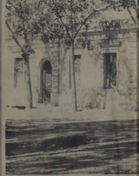
Escuelas fiscales No. 1 y 2, construidas en 1895. Ocupaban el mismo sitio en que fue edificada, en 1942, la actual escuela No. 201 "Bernardino Rivadavia", en la esquina de San Isidro y Alem. En este establecimiento comenzó a funcionar en 1917 la actual escuela normal superior "República de Chile".
