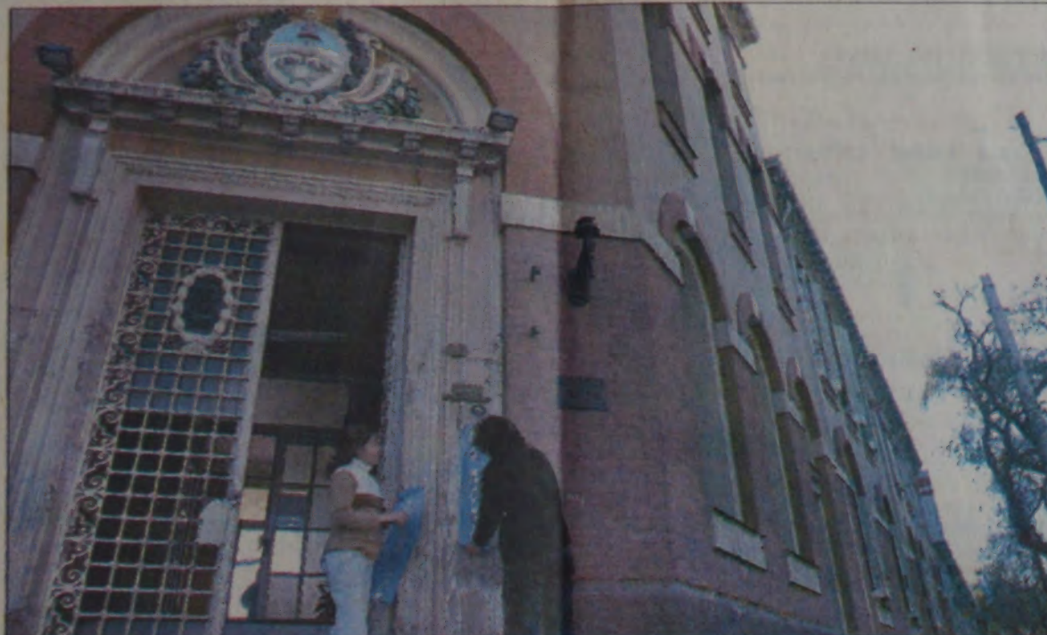
LA FACHADA de la escuela, ubicada frente a la plaza Sarmiento de nuestra ciudad.
