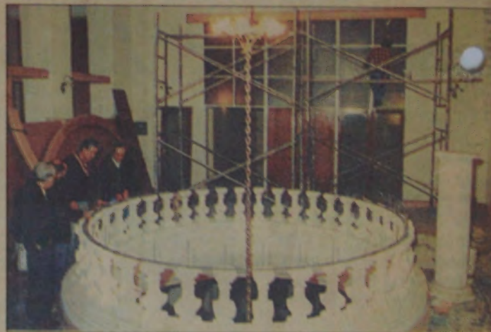
Personal de la Dirección de Planificación del Ministerio de Obras Públicas observando detalles de los trabajos realizados.
