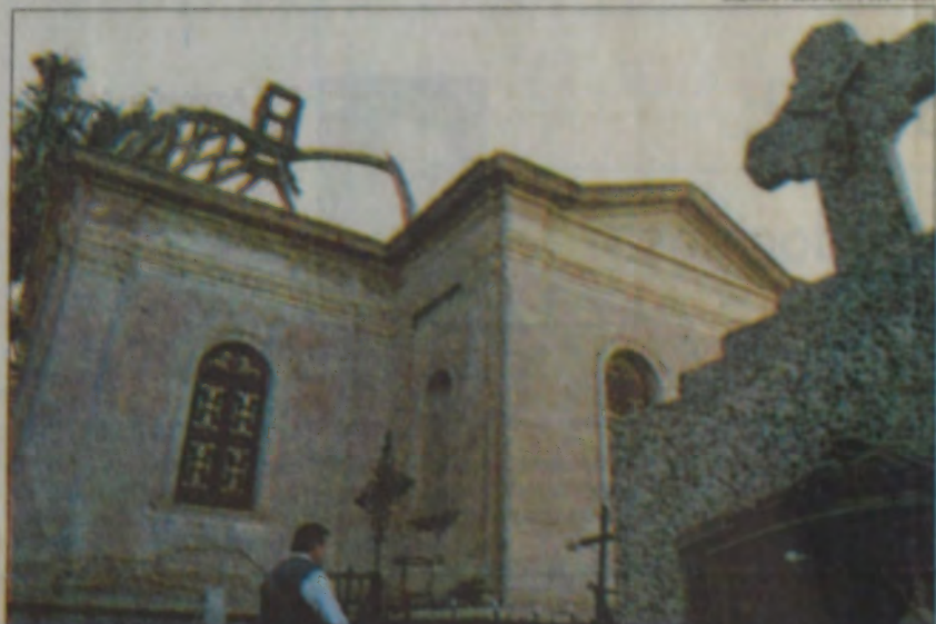
La fachada del cementerio (por Cervantes) y el interior del mismo serán restaurados.
