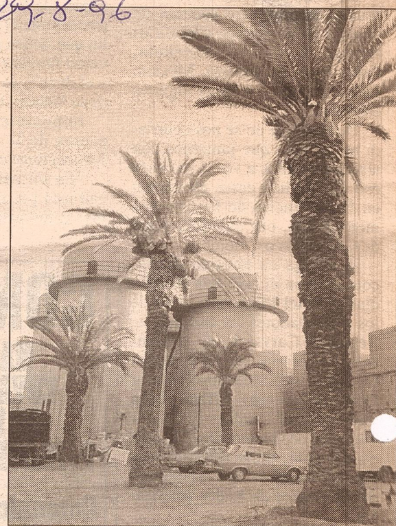
Las piletas de fermentación quedarán en pie.
