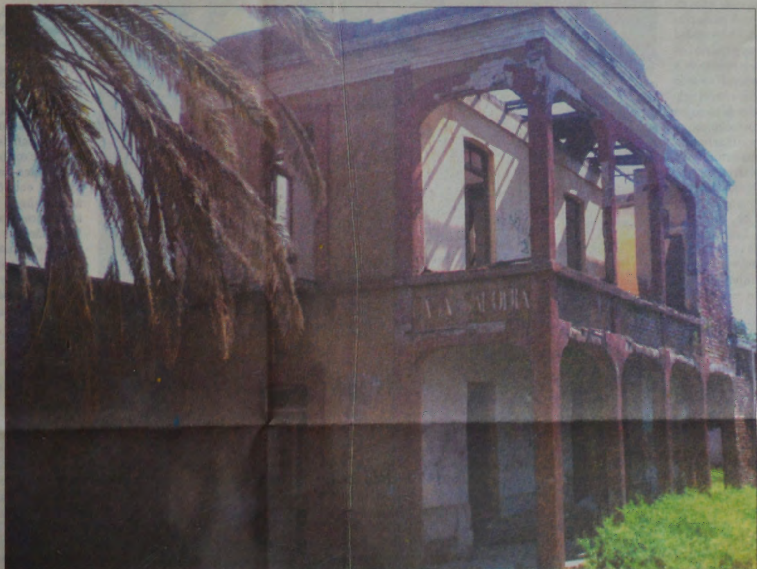
SIN TECHO. Varios especialistas consideran que debe ser demolida porque no es posible recuperar la edificación de la reconocida familia.
