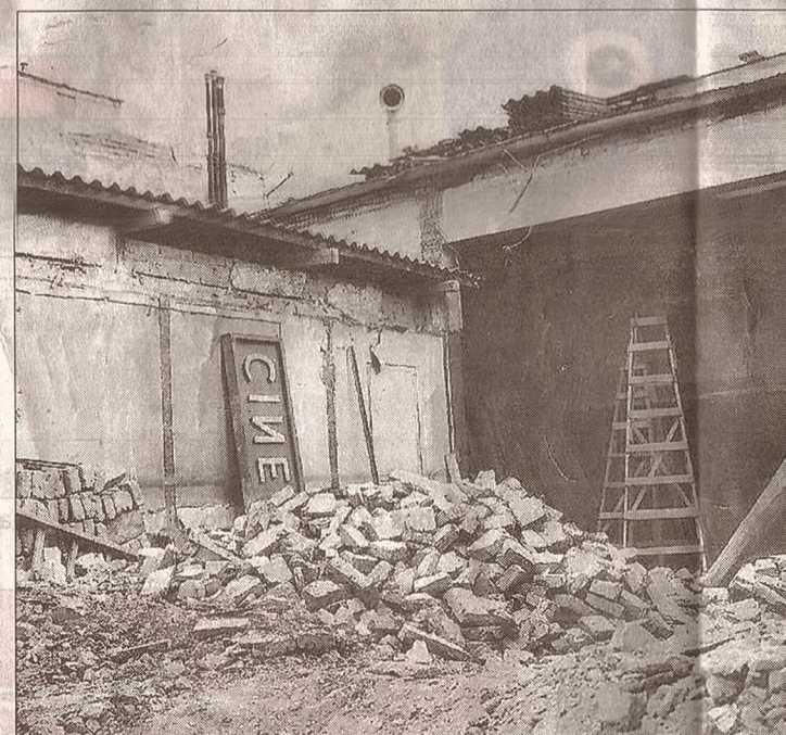
A mediados de los '60 se demolió el edificio del recordado cine.
