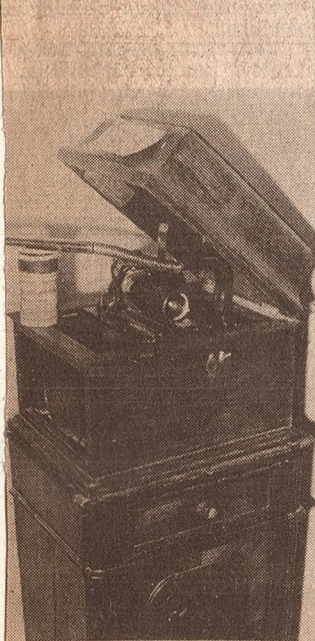
Este fonógrafo-grabador está ubicado en la "Sala costumbrista". Podemos observar claramente la bocina que se utilizaba para emitir la voz y los rodillos que la receptaban y reproducían.
