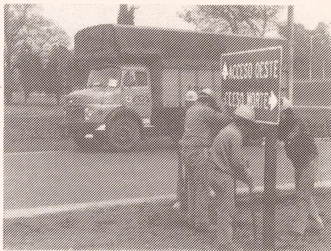
—Colocación de señales
