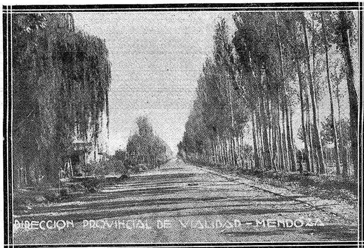
Camino de concreto asfáltico Luján-Blanco Encalada
