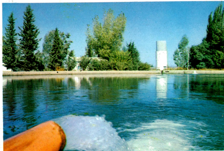
Pozo y tanque para almacenamiento de agua para riego.
