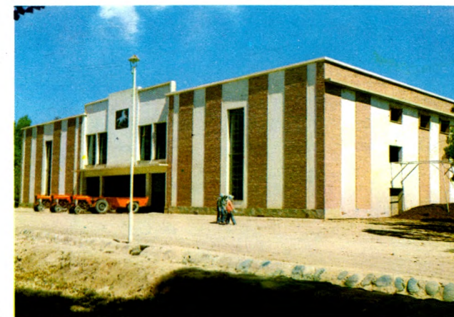
Bodega El Retiro Situada en finca El Retiro de calle La Florida s/n de Los Campamentos Rivadavia—Mendoza.
