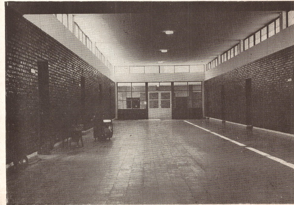
Patio cubierto en el interior de una escuela
