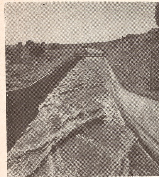
Canal para riego a través de zona árida
