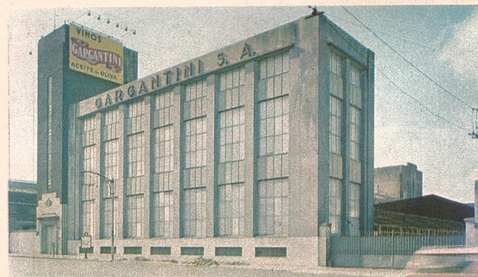
PLANTA DE FRACCIONAMIENTO - BUENOS AIRES Avda. San Martin 3379 Capacidad de Envasamiento 40.000 Cajones Diarios
